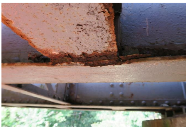
K01 - oslabení hlavního nosníku v místě napojení stoličky.
