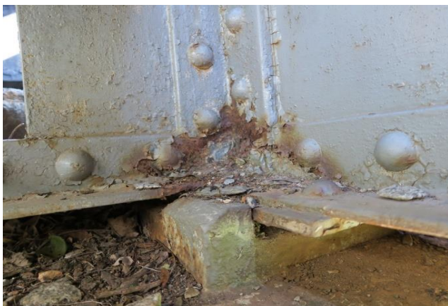
K01 - oslabení příčného ztužení v místě napojení na hlavní nosník na O 01 vlevo.
